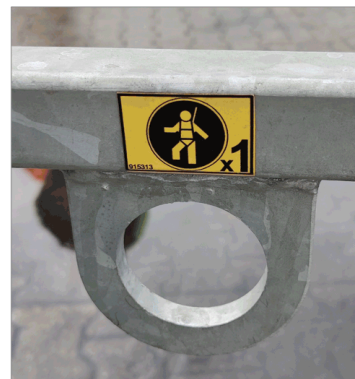
Gekennzeichnete Anschlagpunkt für die PSA gegen Absturz
